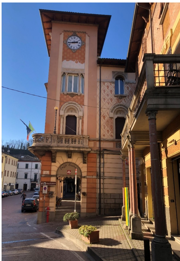
Figura 2: Prospetto Nord - vista della torre del Municipio, da Via Aurelio Saffi.
