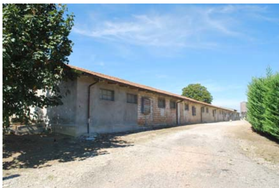
L'edificio da demolire
